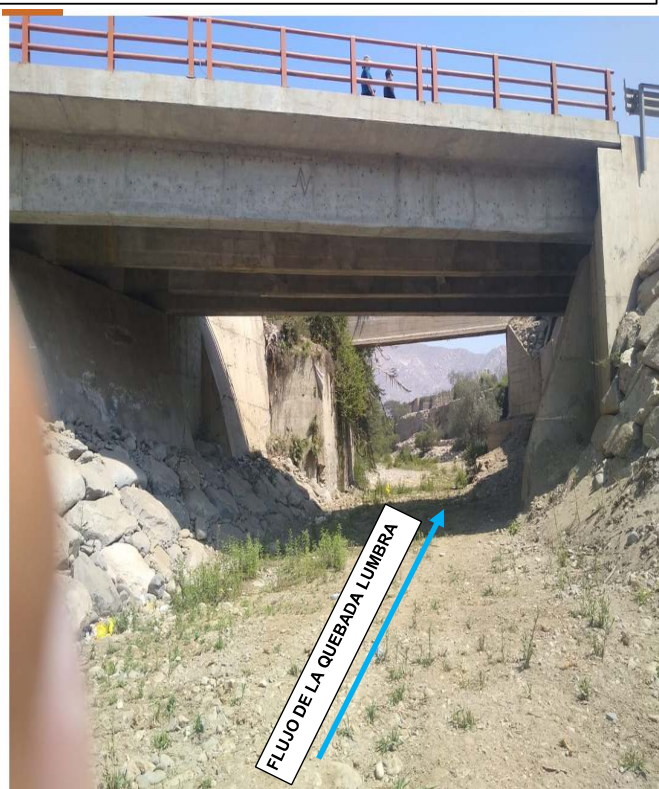
FIGURA N°03: EN LA TEMPORADA DE MAXIMAS AVENIDAS LA QUEBRADA LUMBRA SE DESBORDA, POR LA MARGEN DECHECHA E IZQUIERDA, EN EL SECTOR LUMBRA, DISTRITO DE HUARAL, CUYO TRAMO SE ENCUENTRA COLMATADO Y DESPROTEGIDO, VULNERABLE A LAS VELOCIDADES EROSIVAS DEL RÍO. EN EL TRAMO FINAL LA QUEBRADA LUMBRA DESEMBOCA AL RIO CHANCAY-HUARAL POR LO QUE EN EL PUENTE LUMBRA SE CUENTA CON ENROCADO HACIA AMBAS MARGENES PARA LA PROTECCION DEL
