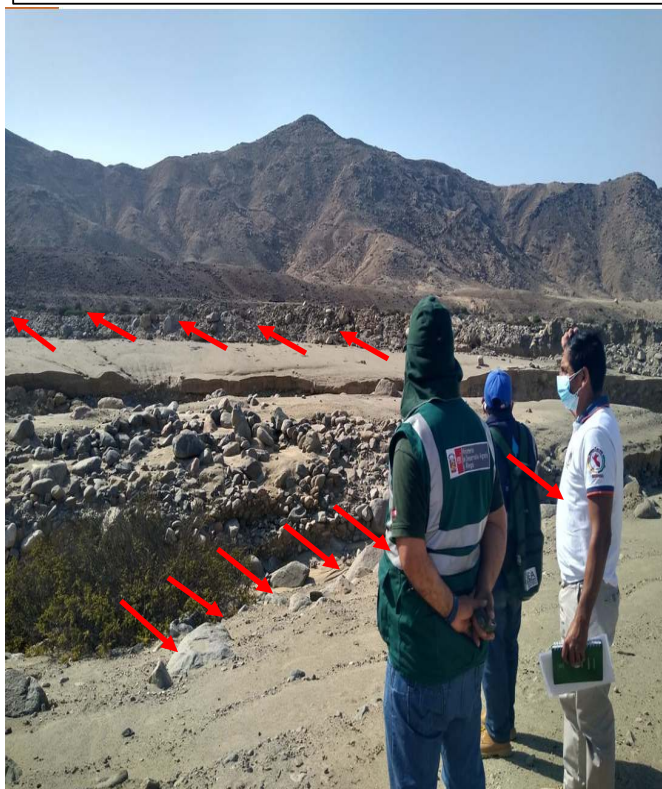
FIGURA N°03: EN LA TEMPORADA DE MAXIMAS AVENIDAS LA QUEBRADA LUMBRA SE DESBORDA, POR LA MARGEN DECHECHA E IZQUIERDA, EN EL SECTOR LUMBRA, DISTRITO DE HUARAL, CUYO TRAMO SE ENCUENTRA COLMATADO Y DESPROTEGIDO, VULNERABLE A LAS VELOCIDADES EROSIVAS DEL RÍO. EN EL TRAMO FINAL LA QUEBRADA LUMBRA DESEMBOCA AL RIO CHANCAY-HUARAL POR LO QUE EN EL PUENTE LUMBRA SE CUENTA CON ENROCADO HACIA AMBAS MARGENES PARA LA PROTECCION DEL
