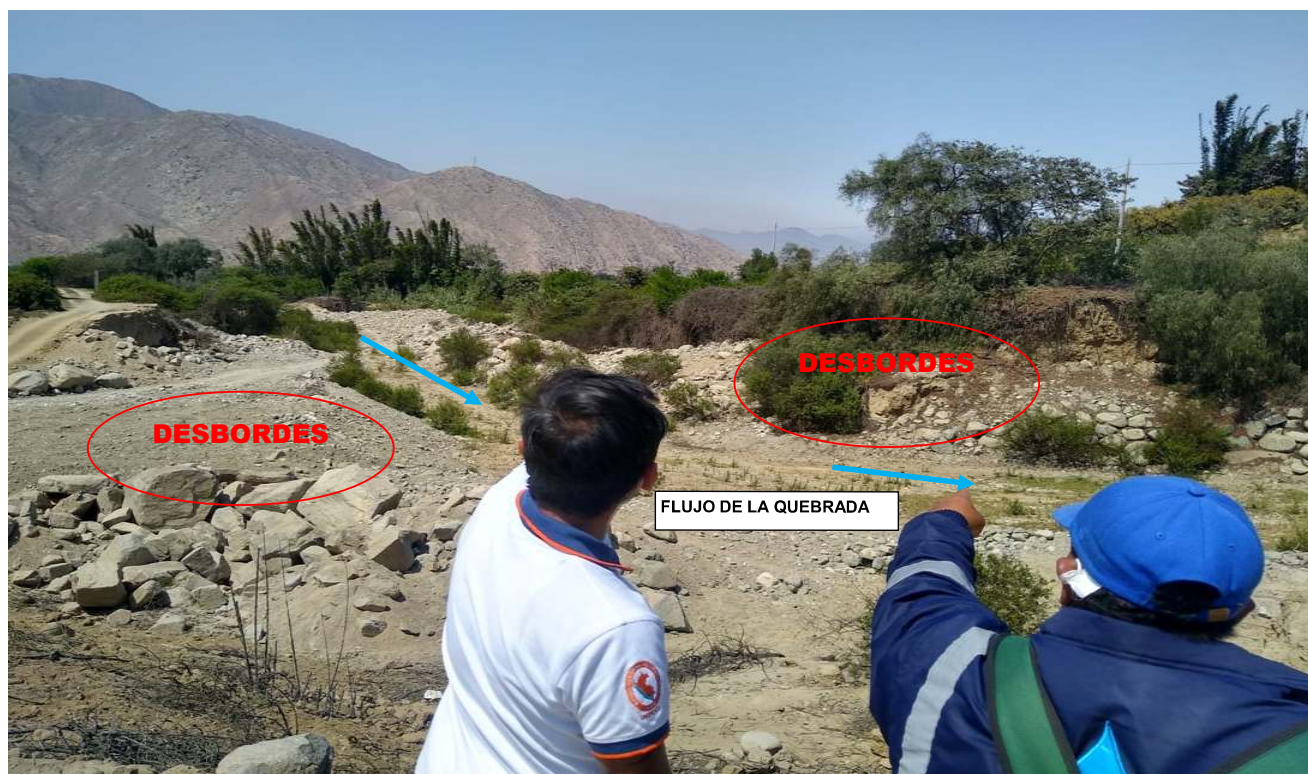
FIGURA N°02: MATERIAL COLMATADO EN EL CAUCE DE LA QUEBRADA LUMBRA, CON UNA PROFUNDIDAD PROMEDIO DE 1.0 M. ESTO PROVOCA EL DESBORDAMIENTO DE LA QUEBRADA SEA MAS INMINENTE.
